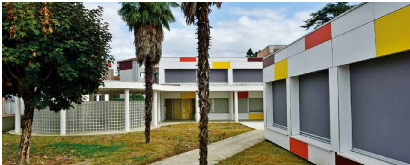
Le collège Clermont, à Pau, a bénéficié d'une restructuration pour un montant de 14,3 millions d'euros.
